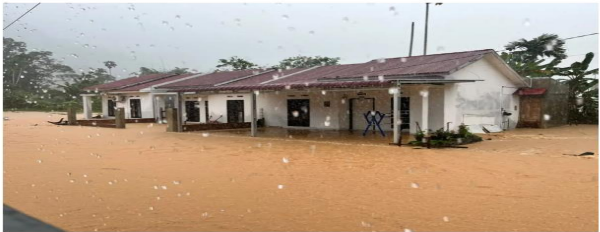
Gambar 1. Sumber Berita: https://posmetropadang.co.id/hujan-dengan-intensitas-tinggi-kembali-rendam-perumahan-permata-utama-lubuk-minturun-warga-desak-penanganan-banjir-428286/
