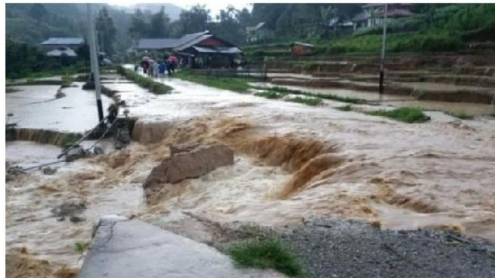
Kondisi jalan provinsi yang ambles akibat banjir di Jorong Tigo Kampung, Nagari Pagaduh, Kecamatan Palupuh, Kabupaten Agam, Sabtu (10/1). Dok ANTARA/HO/Camat Palupuh
